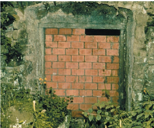
■ Zugemauerter Stolleneingang mit Einflugschlitz für Fledermäuse. Foto: M. BRAUN
