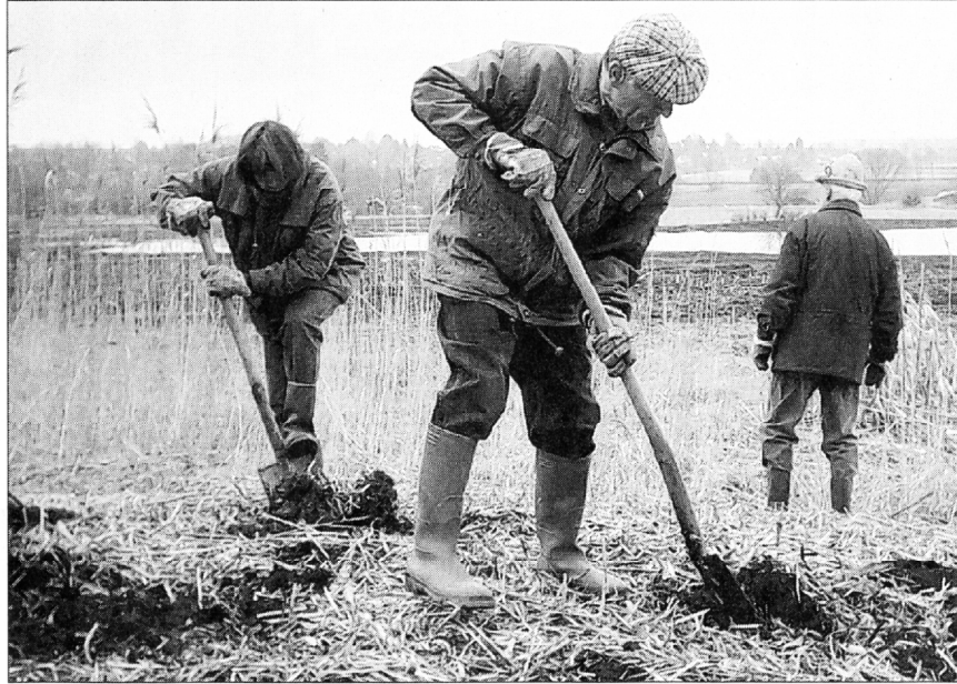
Mit Spaten und in Gummistiefeln haben sich Naturschützer am Samstagvormittag an die Arbeit gemacht: Zwischen Heiningen und Eschenbach entsteht ein Feuchtbiotop, das Vögeln später als Brutplatz dienen soll. FOTO: BORIS-MARC MÜNCH
